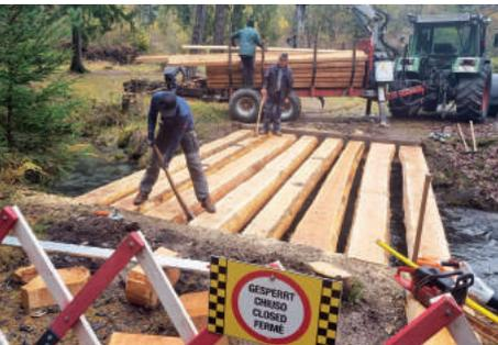
Diese Brücke war in einem schlechten Zustand und erforderte dringend eine Renovierung. Für die Arbeiten wurde Lärchenholz verwendet, was eine langlebige und robuste Lösung darstellt. Die Arbeiten fanden in enger Abstimmung mit der Gemeinde Nassereith statt, sodass sich die Kneippanlage Mühl sprung nun in gänzlich erneuertem Look präsentieren darf.
